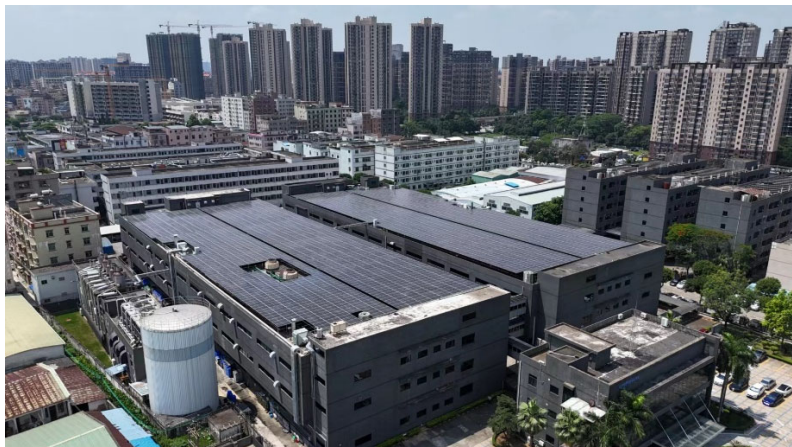
海外生産工場(東莞友華汽車配件有限公司)に 設置された太陽光パネル
